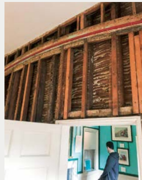
※壁の下地は木造で土塗壁が見えていた1
